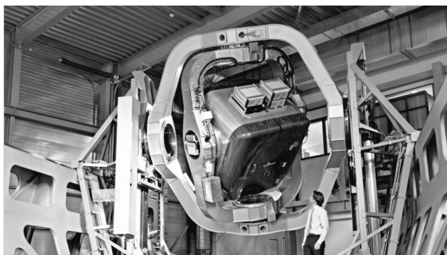
Рис. 2. Тренажер пространственной дезориентации DESDEMONA
